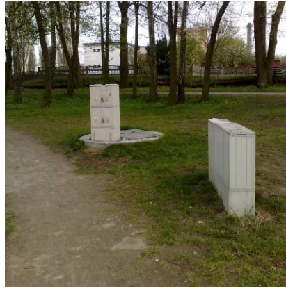
zdj.3. Przepompownia i skrzynki elektryczne w południowo zachodniej części parku (B. Gawryszewska 2010r.)
