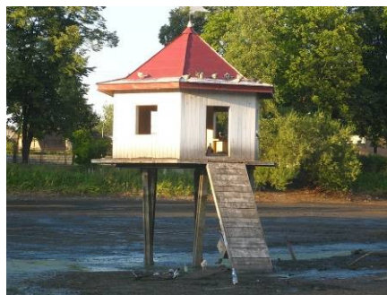
zdj. 8. Domek dla łabędzi podczas prac remontowych Jeziórek
