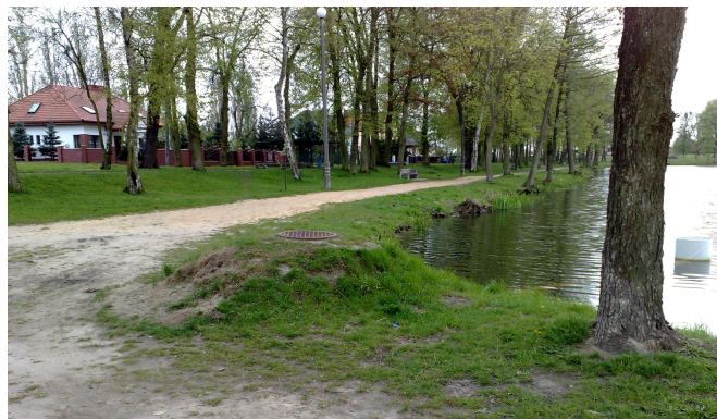
zdj.2. Studnia instalacji kanalizacyjnej (przelew widoczny z prawej części zdjęcia) (B. Gawryszewska 2010r.)
