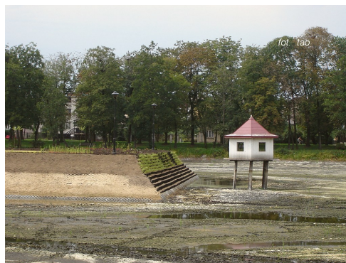
zdj.4. Staw podczas prac remontowych 2008r.: wyspa z umocnionymi skarpami oraz domek dla łabędzi. http://www.sierpc.com.pl/galeria.php?start=1&kategoria=Renowacja+Jezi%F3rek+2008+
