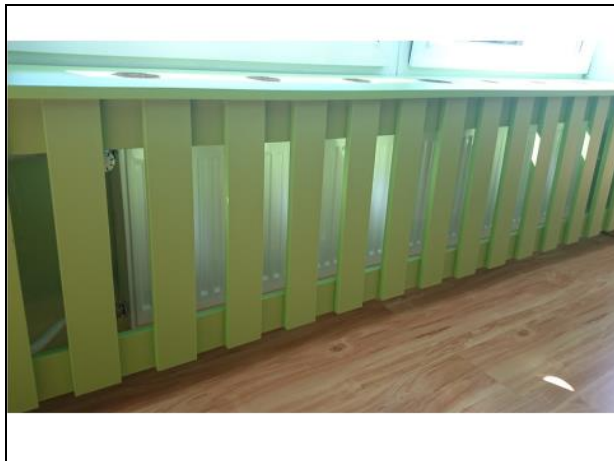
[42. Wymiana instalacji c.o. w MP Nr 2]
