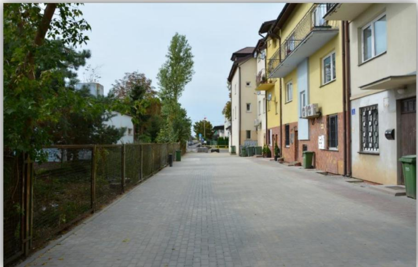
Utwardzenie drogi przy zabudowie szeregowej w Sierpcu pomiędzy Placem Europejskim, a dworcem PKS.
