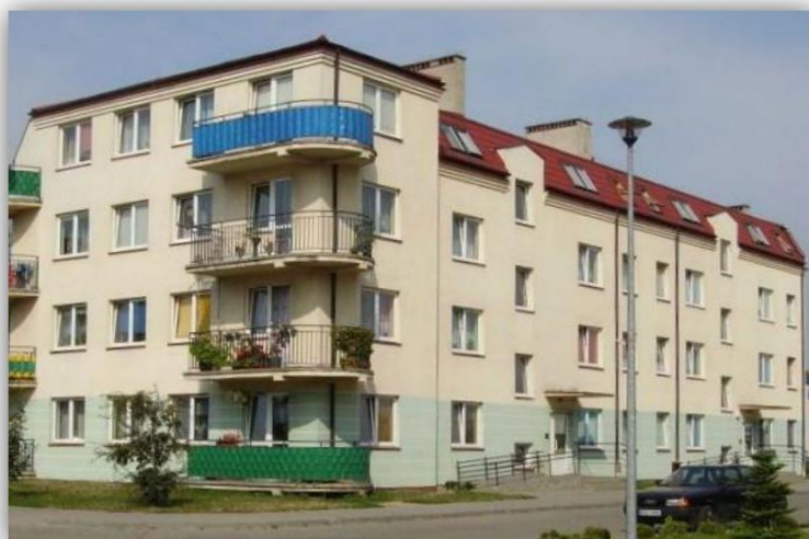
Budynek TBS zlokalizowany przy ul. Płockiej 57a
