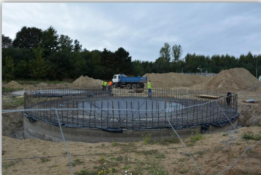
Modernizacja oczyszczalni ścieków
