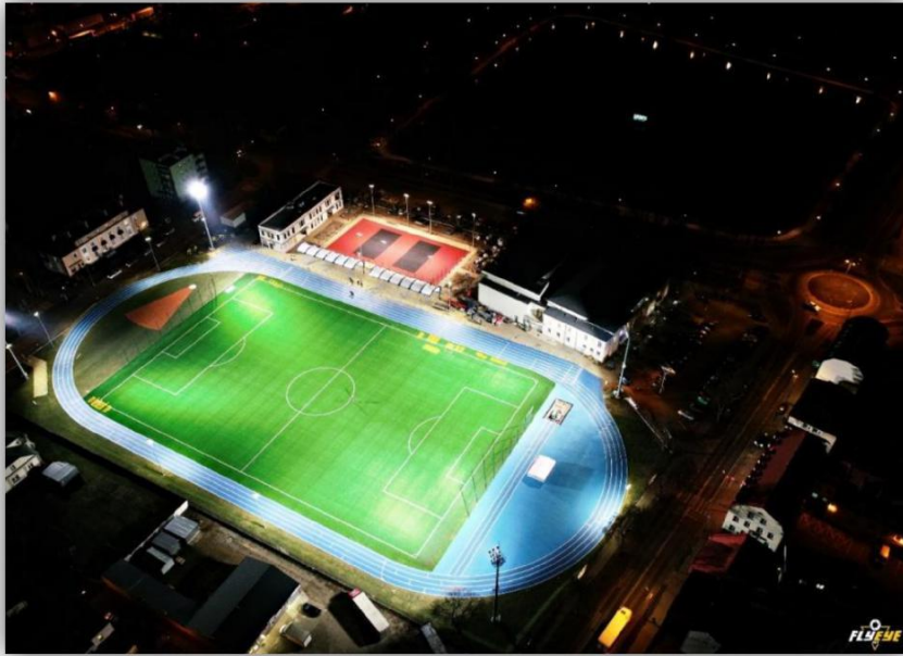
Przebudowa stadionu miejskiego przy ul. Świętokrzyskiej w Sierpcu – budowa boiska piłkarskiego wraz z boiskiem wielofunkcyjnym, oraz urządzeniami i infrastrukturą towarzyszącą.
