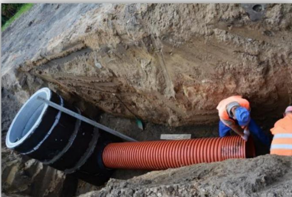
Budowa sieci kanalizacji sanitarnej
