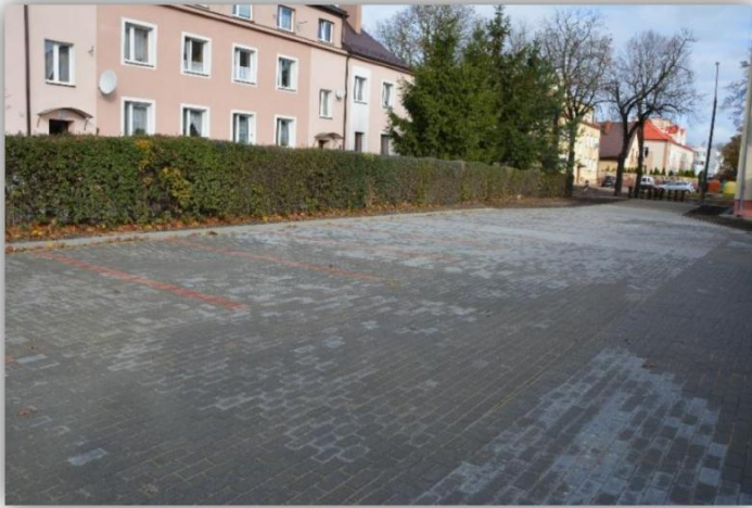
Utwardzenie terenu przy ul. Kasztanowej przy garażach
