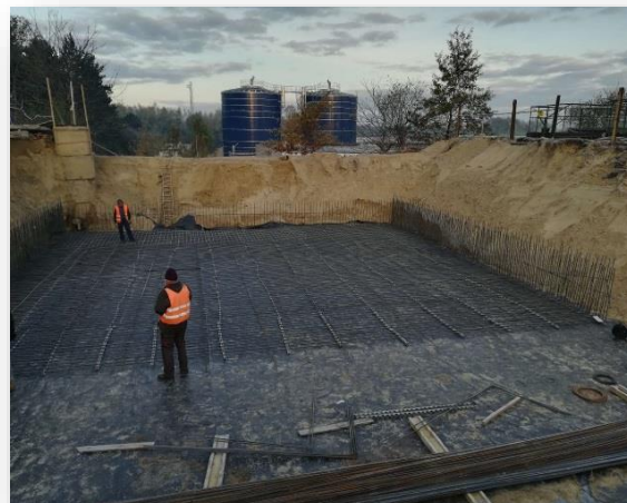
Ryc. 9. Zbrojenie płyty dennej Osadnika wstępnego
