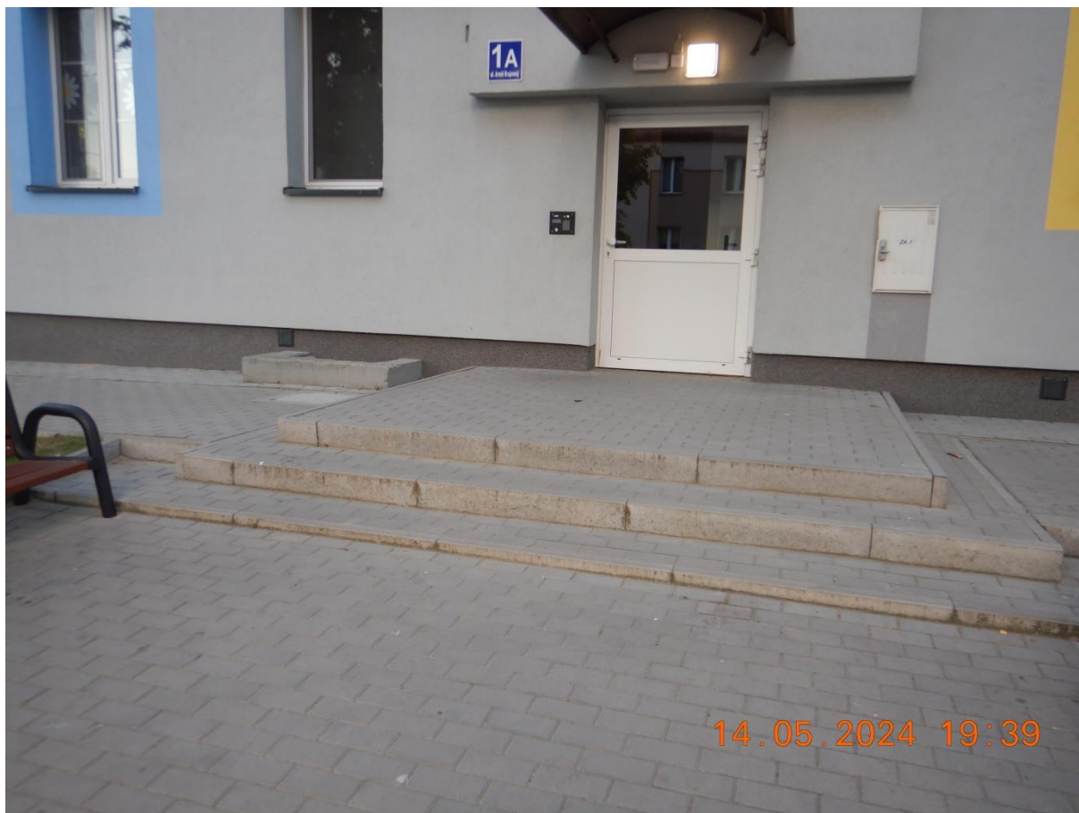
Na chodniku wybudowano schody ...
