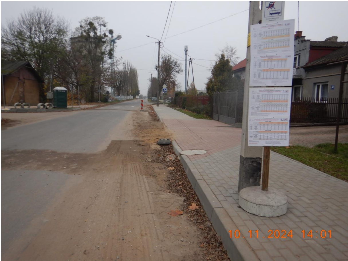
Przystanek komunikacji zastępczej w Sierpcu.
